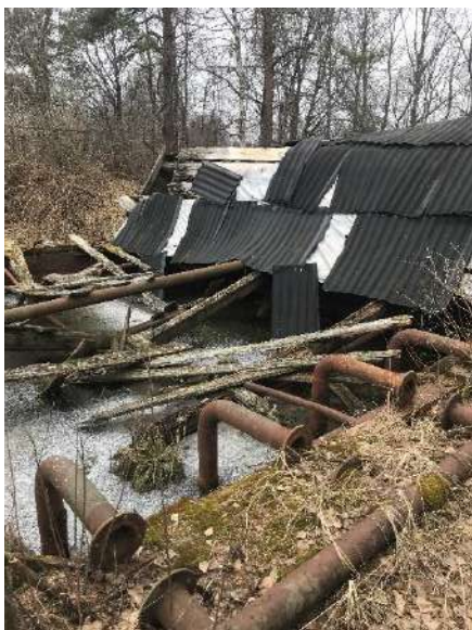
Состояние существующих аэротенков-отстойников
