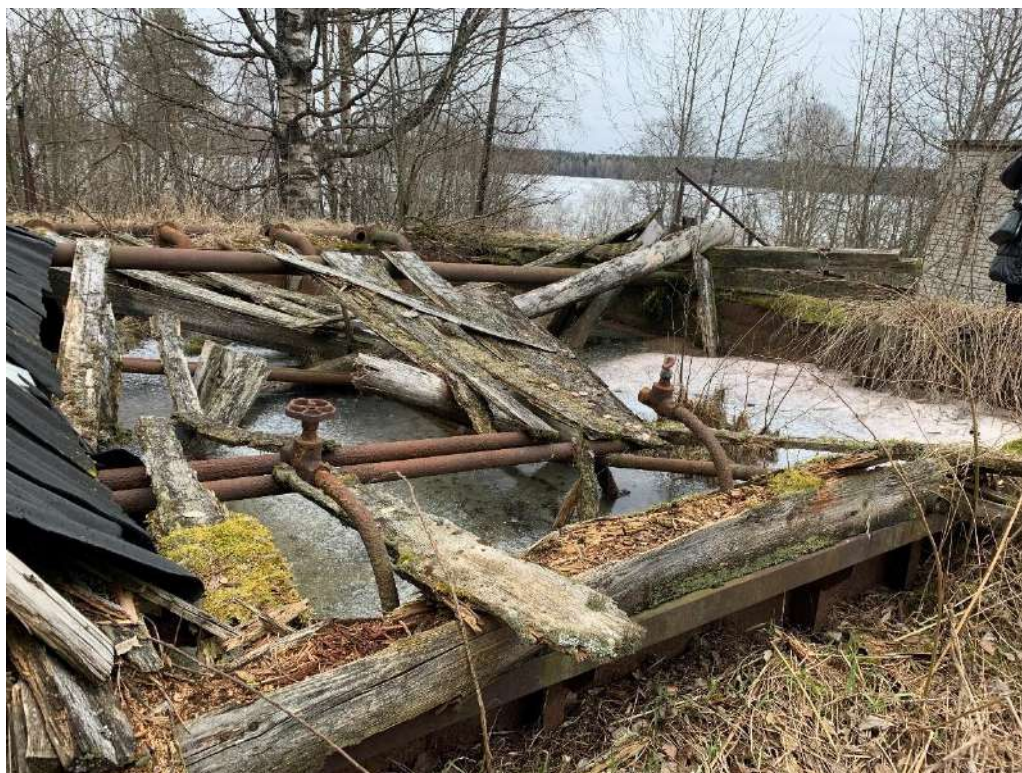
Состояние существующих аэротенков-отстойников
