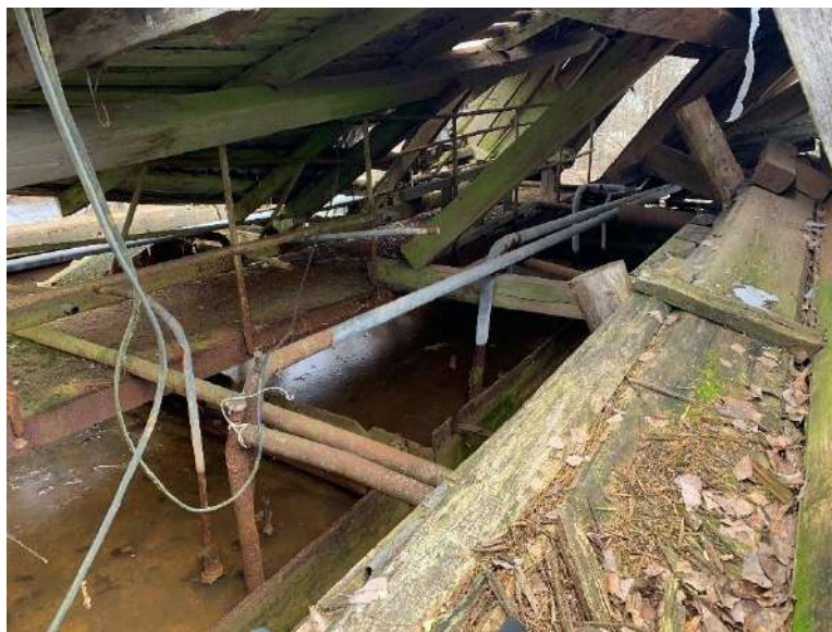
Состояние существующих аэротенков-отстойников
