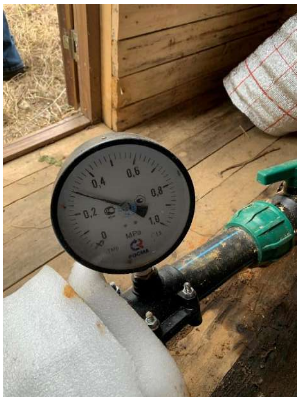
Давление в водораспределительной сети на момент обследования
