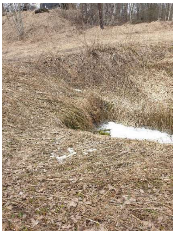
Контактный резервуар (не работающий)
