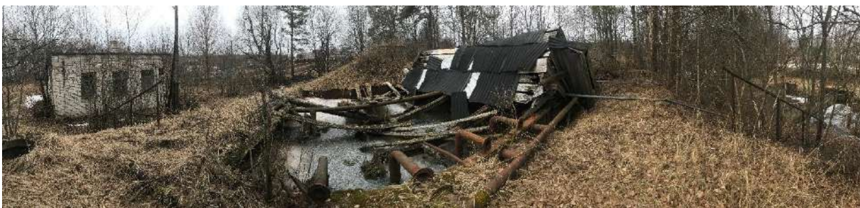
Панорама. Существующие неработающие КОС, вдалеке слева производственное вспомогательное здание
